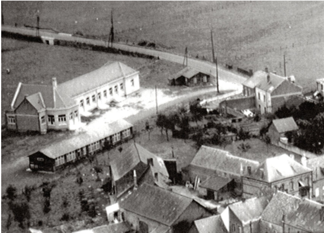
Première partie de la construction, le reste du baraquement et la Mairie en bordure de route.
